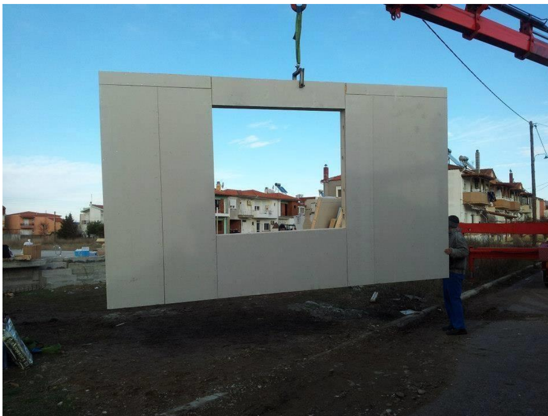
Esempio di pannello di parete prefabbricato: la finitura finale renderà il sistema continuo e non leggibile come semplice giunzione di pannelli.
